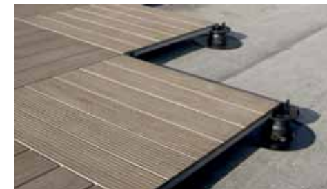
Även på andra hårda ytor som betong och sten. Det går åt ca en fot till varje platta.
