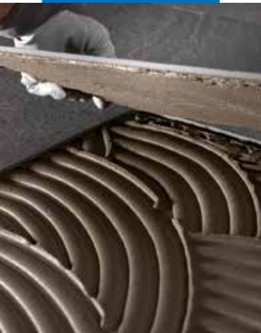
Läggning av tunn porslinskeramik på golv
