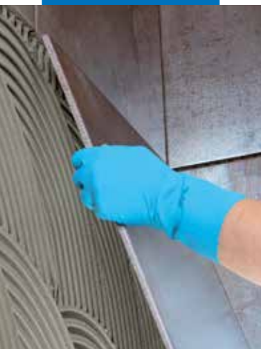
Sättning av stora plattor på väggar
