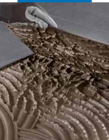
Kontroll av täckning under plattan
