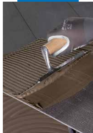
Dubbellimning av golvplattor
