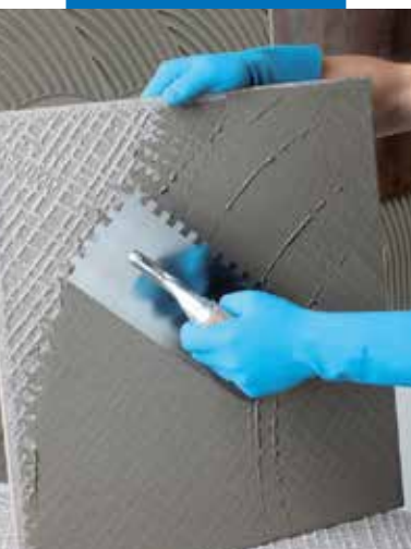
Applicering av fästmassan på baksidan av plattan
